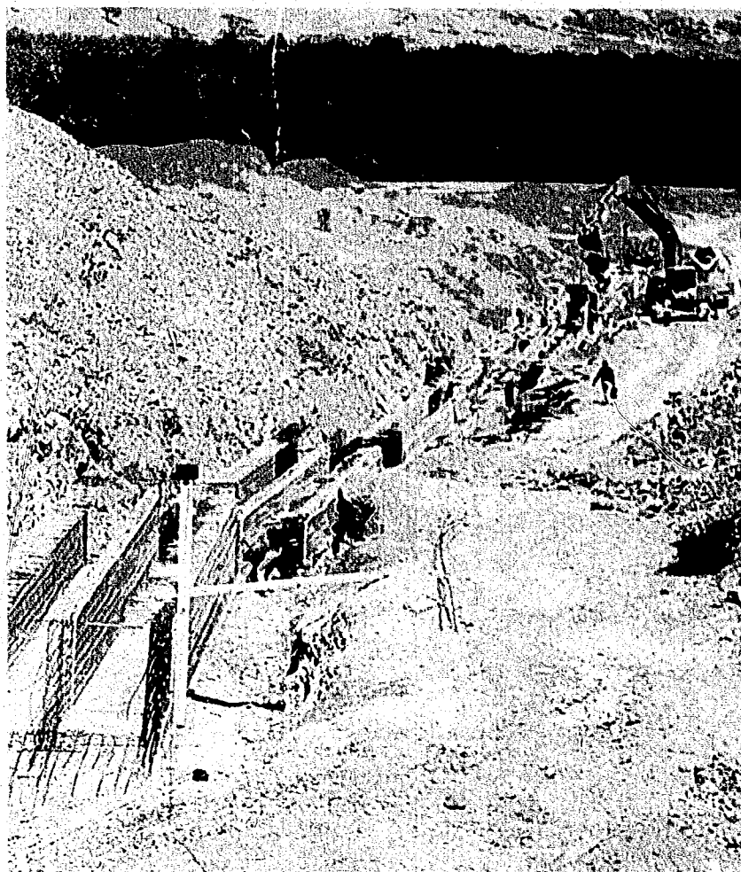
Réalisation d'hors site par l'ANHI
